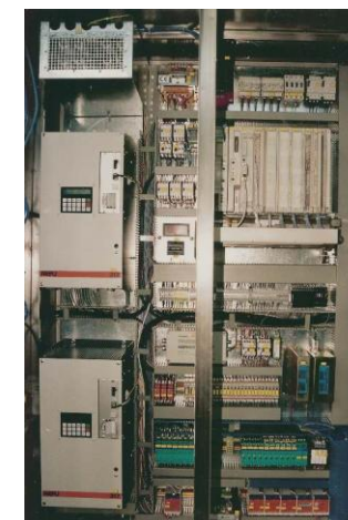
Umbau einer Zentrifugensteuerung
