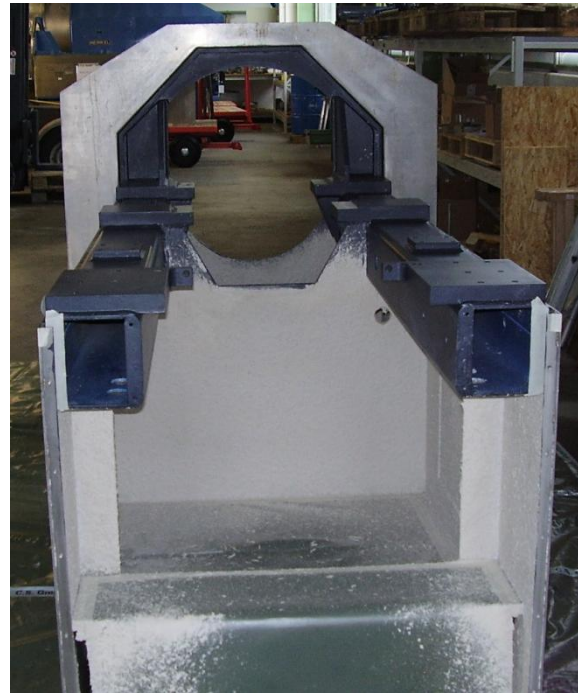
Auftrag des Dämmschutzes
